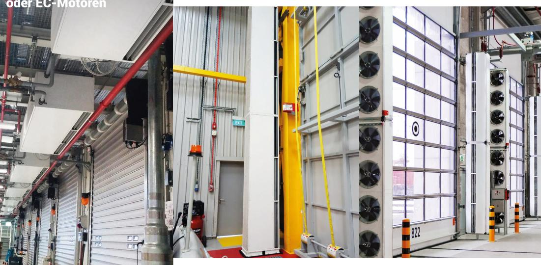
Windbox BB, L und XL Luftschleier-Geräte erzeugen zur Klimatrennung eine effektive Hochdruck-Luftbarriere an Eingängen bis 8m Höhe, und reduzieren die Wärmeverluste bei offenen Toren. Die Montage kann hängend, beidseitig stehend oder in einer Zwischendecke eingebaut sein.
